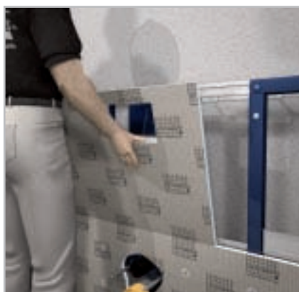
Например, монтаж наружной конструкции
