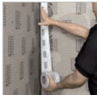
DRY-DB(V) – нанесение гидроизоляционных лент на стыки стены/пол
