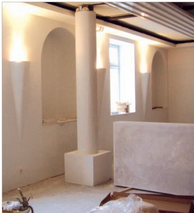
■ ... toutes les poutres, colonnes et parois de séparation ont été recouvert(e)s à l'aide d'éléments porteurs en mousse dure de LUX ELEMENTS.
