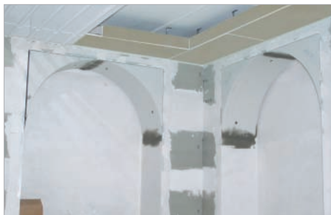
■ ... les voûtes au dessus des fenêtres condamnées et ...
