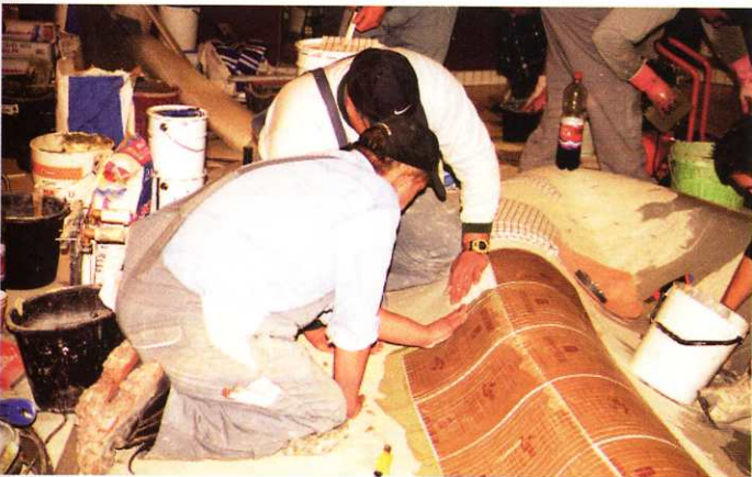
Fliesenarbeiten an der wulstförmigen Teichanlage.
