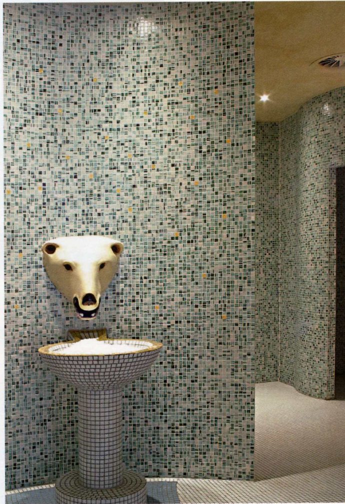
Detail des Eisbrunnens: Die Verlegung der Mosaik erfolgte direkt auf die vorgefertigten Rundwandelemente.
