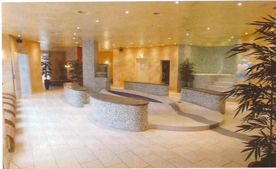
Das Kasseler Wellness Resort nach der Fertigstellung. Alle geschwungenen Formen wurden mit Hartschaumträgerelementen von Lux Elements ausgeführt.
