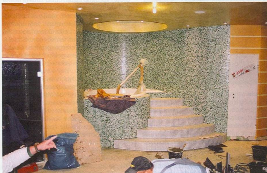
Das Tauchbecken während der Bauphase
