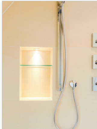
■ Die Installation unterschiedlichster Lichtsysteme ist problemlos machbar, wenn die Dauertemperatur nicht über 75 °C liegt.
