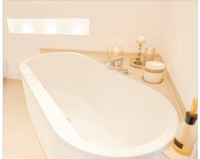
■ Hinter der schräg stehenden Badewanne befindet sich ein Podest mit großzügiger Ablagefläche. Podest und Wannerverkleidung sind aus Hartschaum-Trägerplatten.
