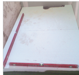
■ Dusche im Aufbau: Das Unterbauelement wird auf dem Boden auf Ansetzkleber COL-AK verklebt und die Aussparung für den Rohrverlauf ausgeschnitten. Mit der Wasserwaage wird die gerade Ausrichtung überprüft ...
