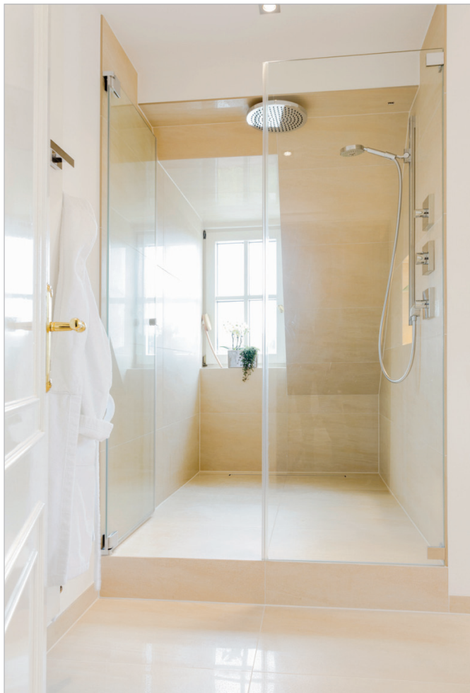
■ Da im Geschossboden zu wenig Aufbauhöhe für die Ablauftechnik vorhanden war, wurde eine Step-Up-Lösung gewählt.
