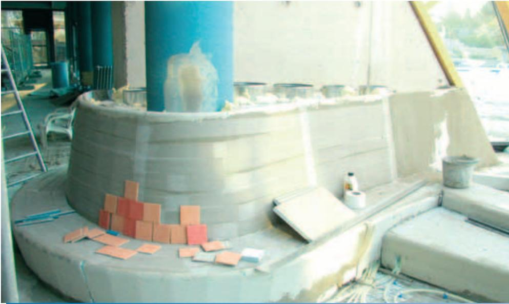
Als wasserfeste Unterkonstruktion für die geschwungenen Sitzbänke und Stufen kamen Hartschaum-Trägerelemente von Lux Elements zum Einsatz.
