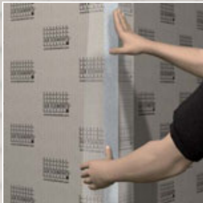
L'armature d'angles nécessite l'utilisation de bandes d'armature autocollantes un peu plus larges.
