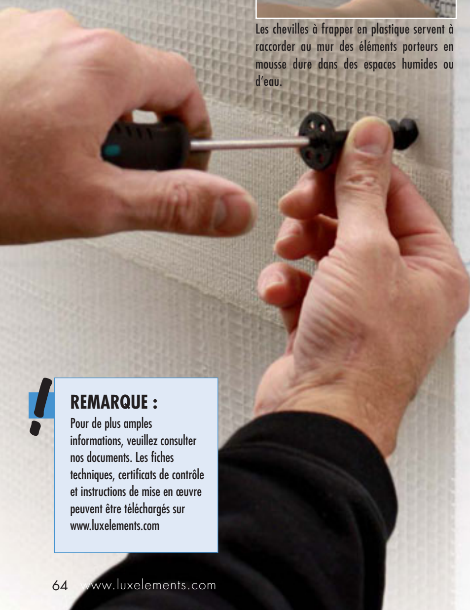
Les chevilles à visser en plastique permettent de raccorder des éléments porteurs en mousse dure les uns aux autres.
