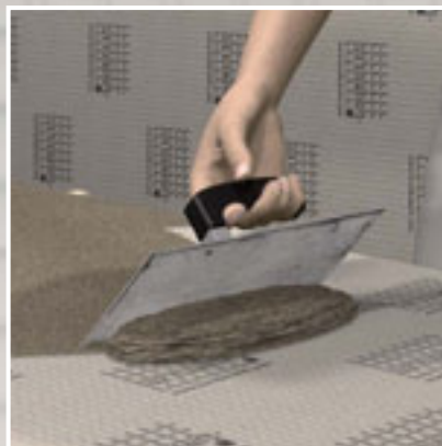
L'application de la colle d'application avec une truelle lisse est recommandée, par exemple, pour faire office de couche de contact.
