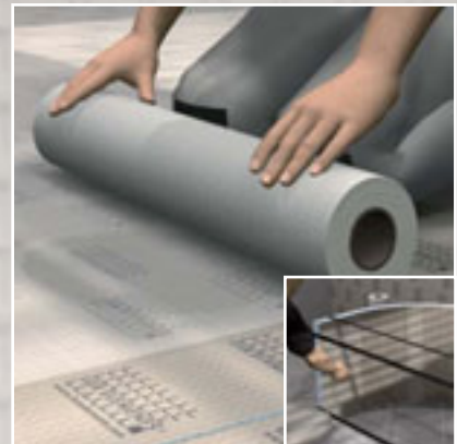
Au sol et sur les grandes surfaces, il convient d'employer une bande d'armature particulièrement large, qui est enrobée dans la surface, puis jointoyée avec de la colle d'application.
