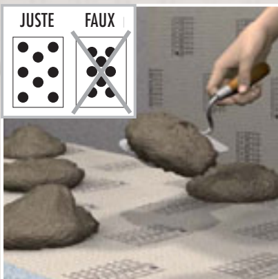
Pour une égalisation de hauteur sur des supports irréguliers, appliquer de la colle d'application ponctuellement au moyen de galettes de colle (8 à 10 galettes par m 2 ).
