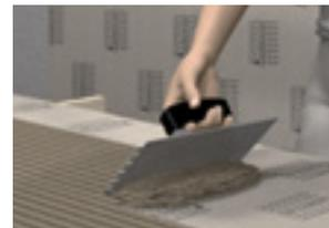
En cas d'utilisation de ELEMENT-EL Baby 4, **toujours** appliquer le colle de montage COL-AK au moyen d'une spatule dentée.
