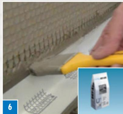
**6** Enduire les surfaces et joints adjacents avec l'enduit d'étanchéité DRY-ASK.
