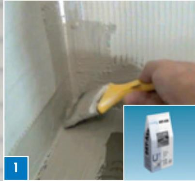
**1** Pour garantir l'étanchéité du receveur de douche, enduire les bords et les angles avec enduit d'étanchéité DRY-ASK.
