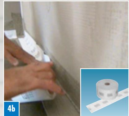
**4b** ... avec l'enduit d'étanchéité DRY-ASK et la bande d'étanchéité DRY-DB.
