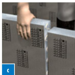
Pour réaliser si besoin une surface de collage absolument plane, il faut poncer au préalable les bords d'élément porteur en mousse dure. Utilisez pour ce faire une planche à polir.
