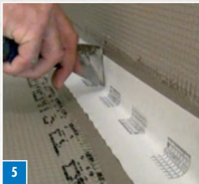
**5** Appuyer sur la bande d'étanchéité avec une truelle à lisser.
