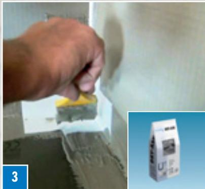
**3** Dans la deuxième étape, le conjoinction est nivelée à l'aide de DRY-ASK enduit d'étanchéité.
