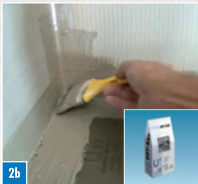
**2b** Enduire le côté intérieur du seuil et le reste du receveur de douche avec l'enduit d'étanchéité DRY-ASK ...
