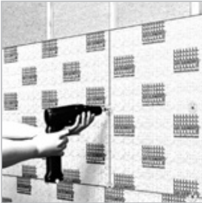
Wall cladding on stud frames
